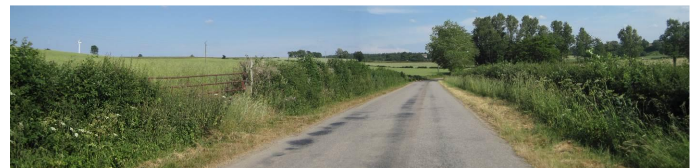
Photo 22 : Voies de circulation desservant l'AER (RD 996, RD 25, croisement entre RD 25 et voie secondaire au sud du Buissonnet, et RD 19)
